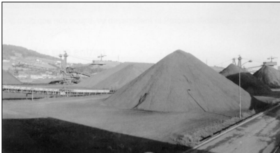
Almacenamiento de minerales
